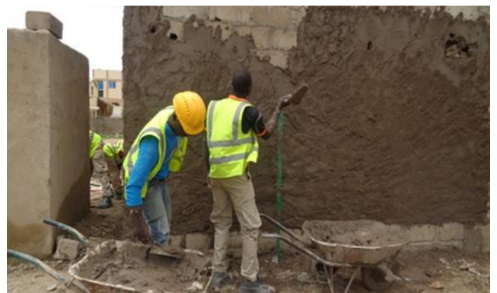
Pratique pour les apprenants aux métiers du bâtiment © Julien Kinda/COFEC
